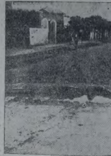
CON LA PAVIMENTACION DE LA CALLE INDIO SE PLANTEA CON urgencia, no sólo el problema del desmonte de las calles transversales, sino el de los desagües. He aquí un ejemplo típico: el cruce de las calles Indio y Cortina. El antiguo paso de piedra ha quedado hundido, y es hoy una zanja sin salida, y será mañana, si el departamento ejecutivo no cumple pronto el proyecto del concejal socialista Miguel Bruiolo, un pantano.
