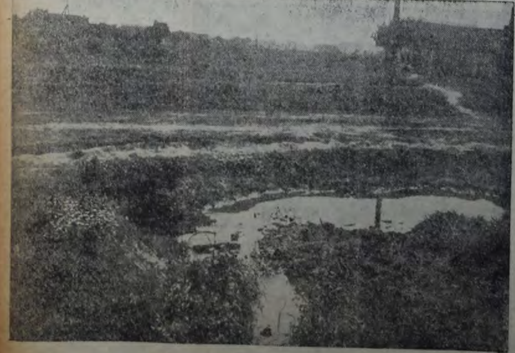
GAONA Y MOLIERE. LA ZANJA DE DESAGÜE, POR FALTA DE UNA LIMPIEZA REGULAR, HA IDO RELLENÁNDOSE DE TIERRA Y BASURA y está hoy a nivel de la calle. Para remediar el mal, en Molière, tocando a Gaona y frente mismo al puente sobre el arroyo Maldonado, se ha formado un enorme pozo que dificulta el tránsito de peatones en día normal, y lo hace peligroso en días de lluvia.
